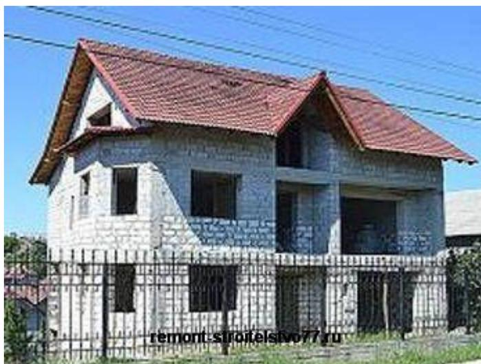
Рисунок 1 – Пример стен из известняка
